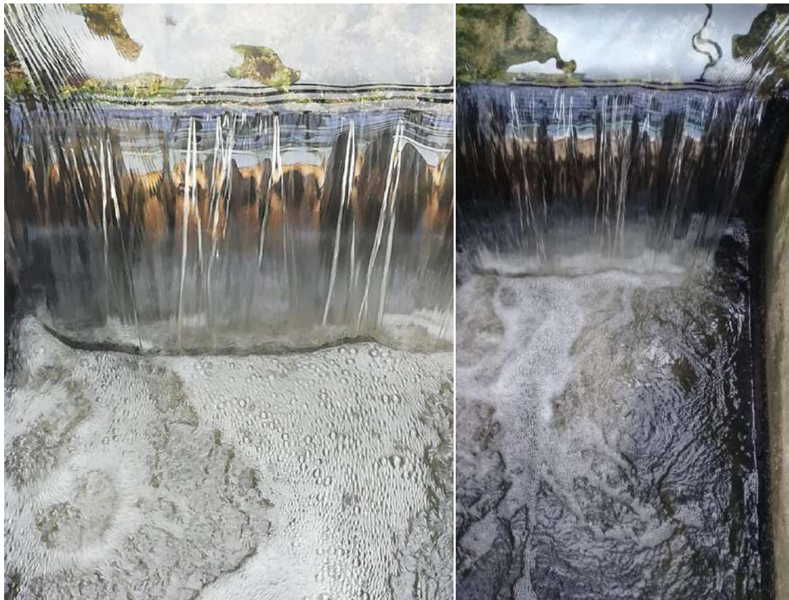
Foto 3 – Scarico dell’Impianto di depurazione
