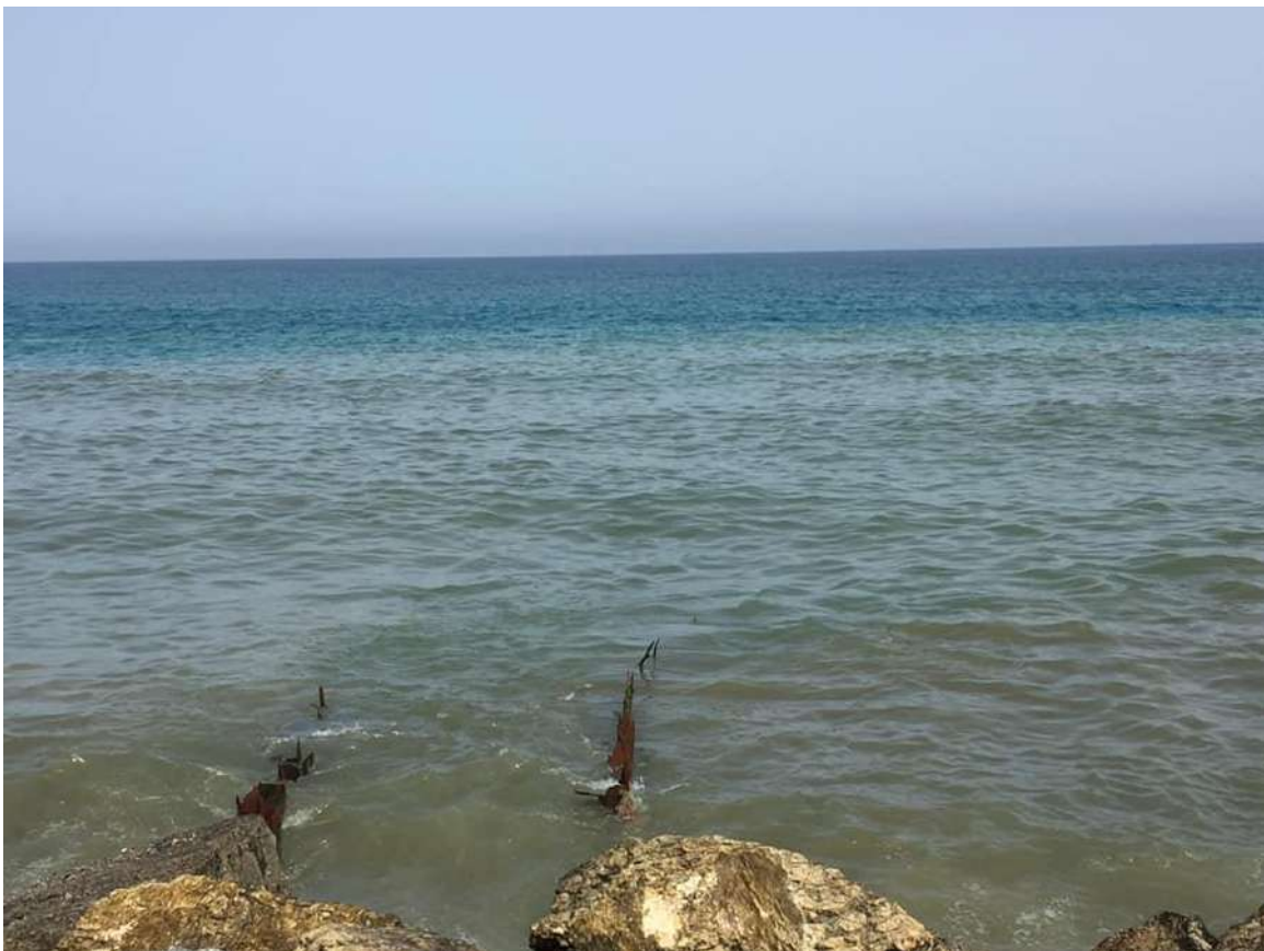
Foto 4 – Scarico dell’Impianto di depurazione
