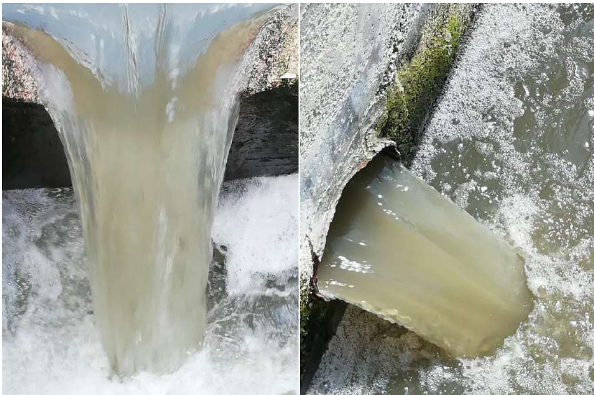
Foto 2 – Scarico dell'Impianto di depurazione
